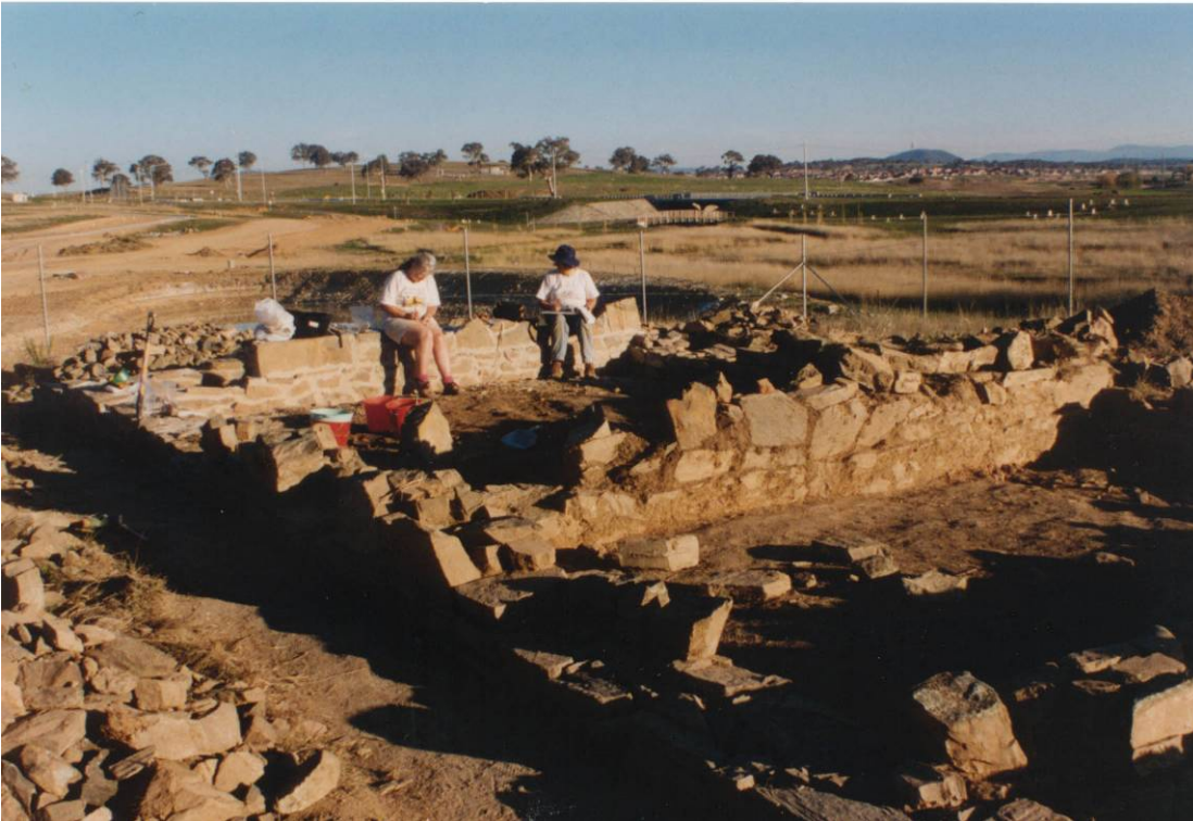
Conservation of Crinigan' Hut, 1992, M Folger
